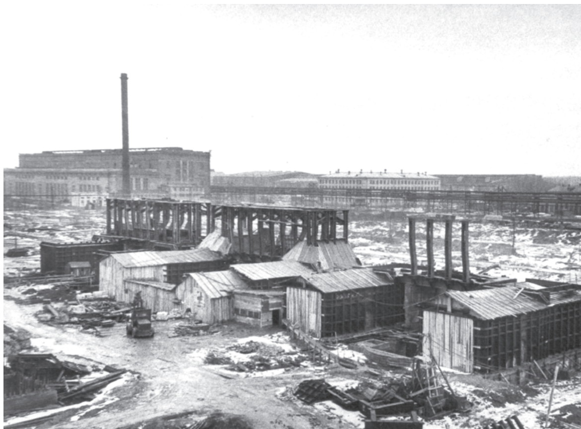
Строительство цеха 121 шло непросто, но уже тогда было понятно, что с возведением цеховых стен и вводом в свой нового оборудование ижорская металлургия выйдет на новый виток развития
