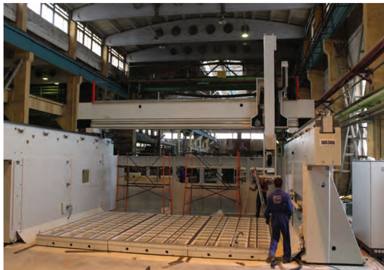
Работы по монтажу станка проводят итальянские специалисты - представители фирмы CMS Industries
