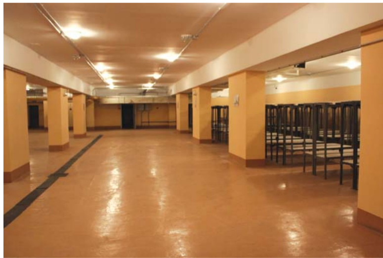
Бомбоубежище цеха №66 было отремонтировано силами Стройтреста №35
