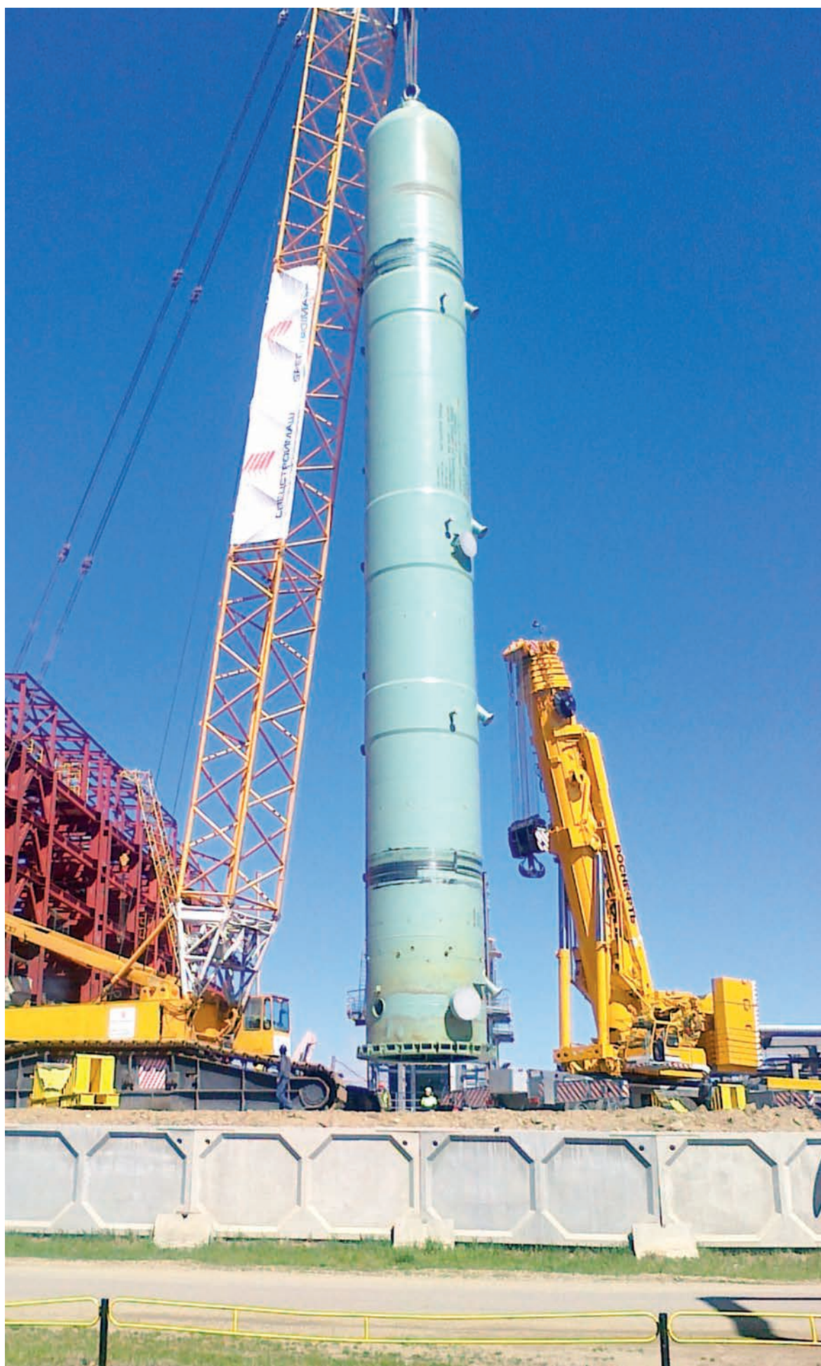
Ижорские заводы завершили установку в проектное положение двух реакторов Р-201 на площадке ОАО «Ангарская нефтехимическая компания».
