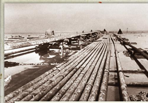
Трубы, собранные в секции, на испытательном стенде. Май 1942 г.
